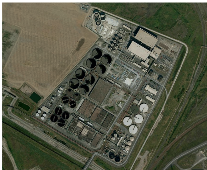
Afb. 1: Bran Sands Afvalwaterbehandeling
